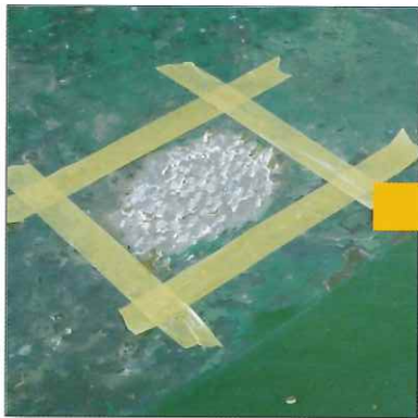
①施工箇所を養生します
