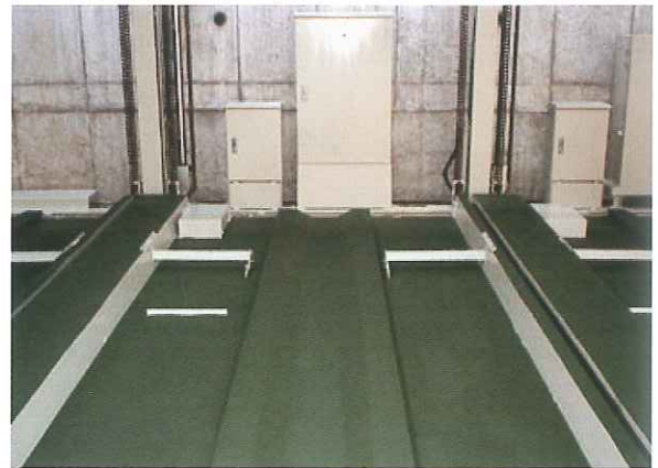
立体駐車場床面 K-888塗布
