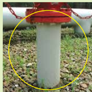
消火栓地際部
