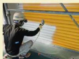
吹付塗装／シャッター
