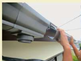
樋交換／軒まわり
