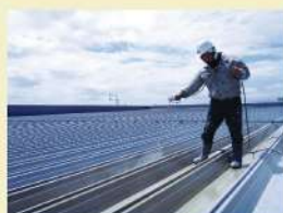
熱交換（遮熱）塗装／金属屋根
