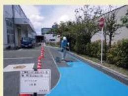
カラー舗装／屋外通路
