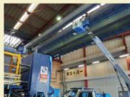
鉄骨塗装／工場内部
