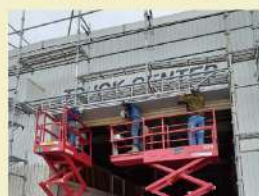
交換・修理／シャッター
