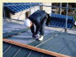
カバー工法／瓦葺屋根
