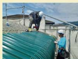
カバー工法／スレート屋根
