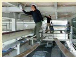
鉄骨塗装／キャノピー
